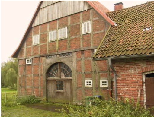
Bild: altes Gebäude des Hofes Oberkönig
