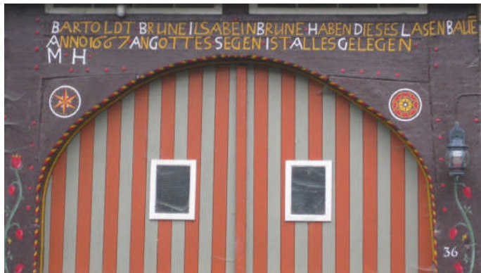
Bild: Wehren-Nr-10-Brune Hausinschrift
