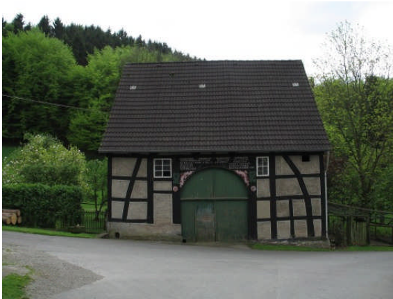
Bild: alter Speicher
